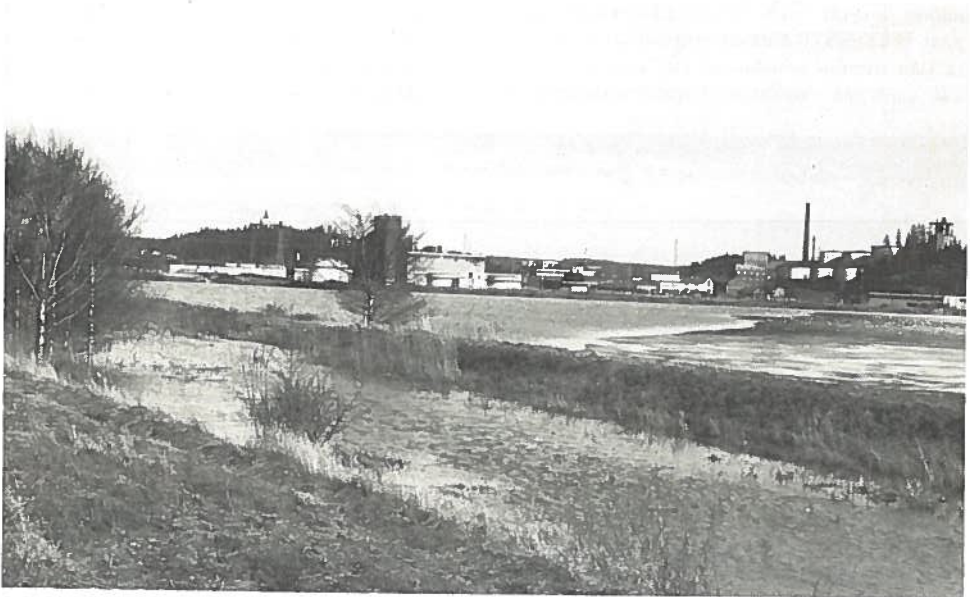
Etualalla vanhan vedenpuhdistamon altaita, joita vesilinnut käyttävät vielä levähdys- ja ruokailupaikkoinaan Taustalla uusi vedenpuhdistamo ja sokeritehdas. Kuva: Antti Nyman
